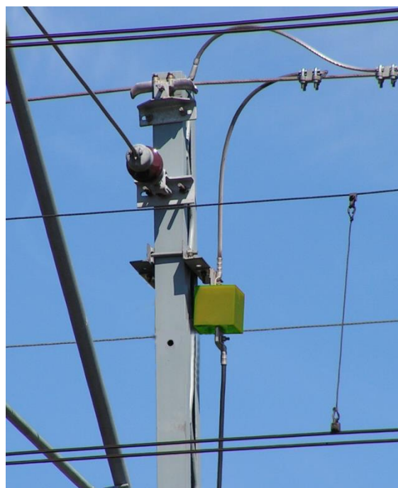
Rys. 1. Ograniczniki TZD-1NR - mocowanie na słupie
