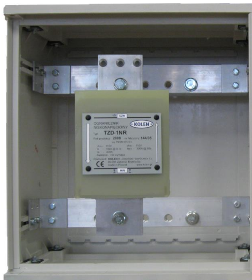
Rys. 2. Ogranicznik TZD-1NR (TZD-1NR/T) w obudowie OS
